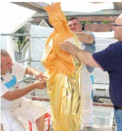
In luftiger Höhe wird gearbeitet.
